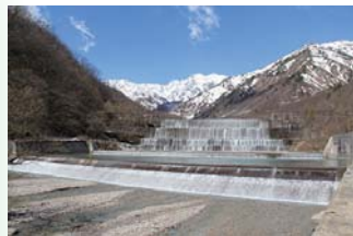
平川頭首工の取水堰堤
